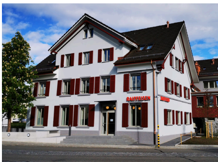
Aussenansicht Geschäftsstelle Birmensdorf (ehm. Restaurant Sonne)
